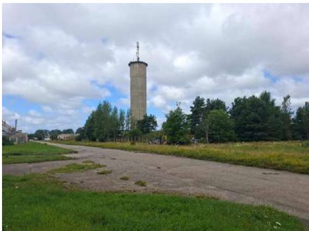
Skats uz ūdenstornā ēku, kadastra apzīmējums 17000110026031
